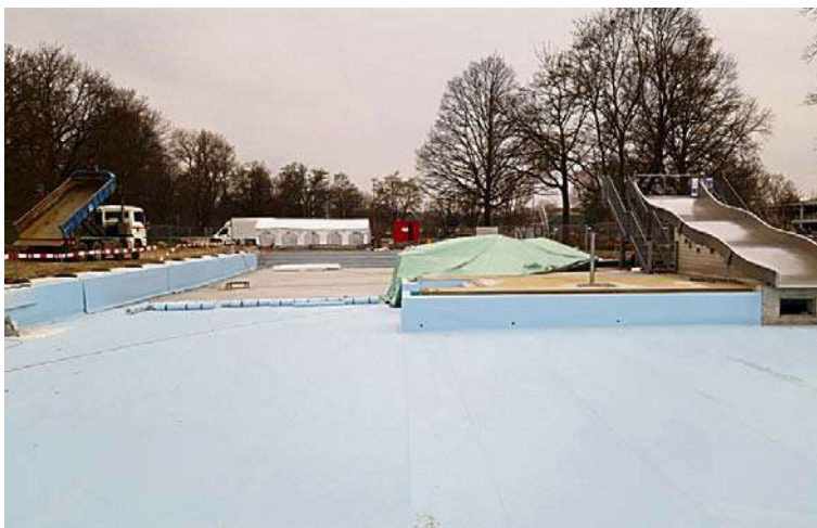
Das Bachgraben wurde neu saniert.
